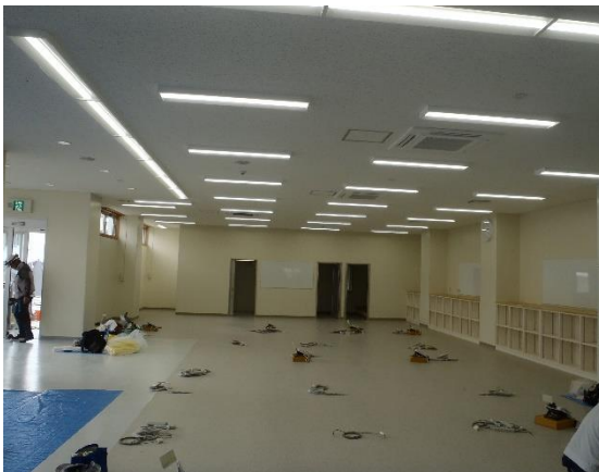
小禄支所 2階 事務室
