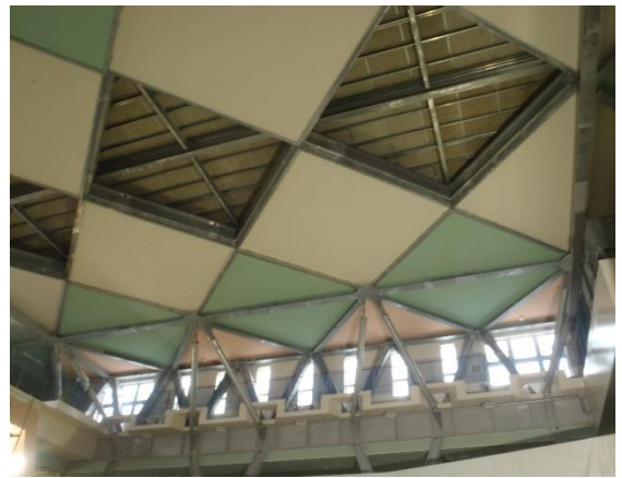
内部 吹き抜け部天井 現況
