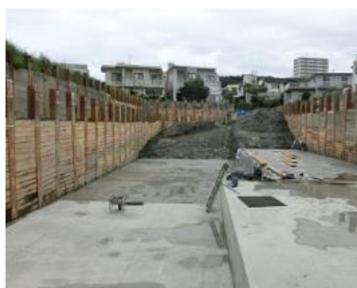
既施工部から施工箇所
