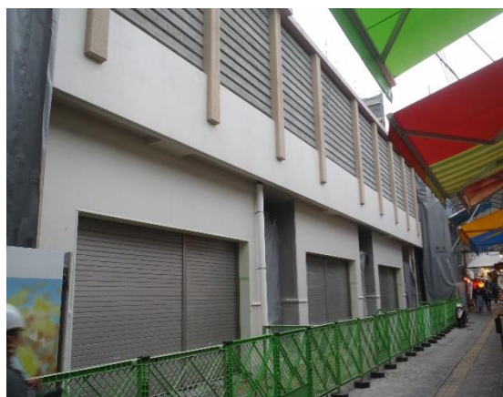
外部 北面 現況
