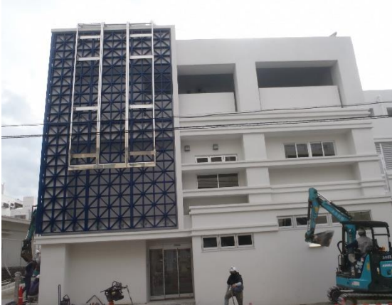
外部 北面 現況
