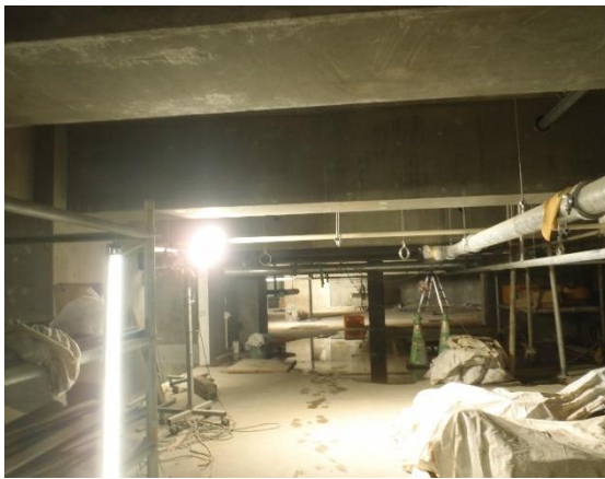
地下1階 ピット部 現況
