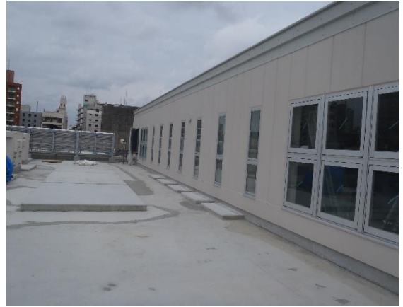
屋上 室外機置場 現況
