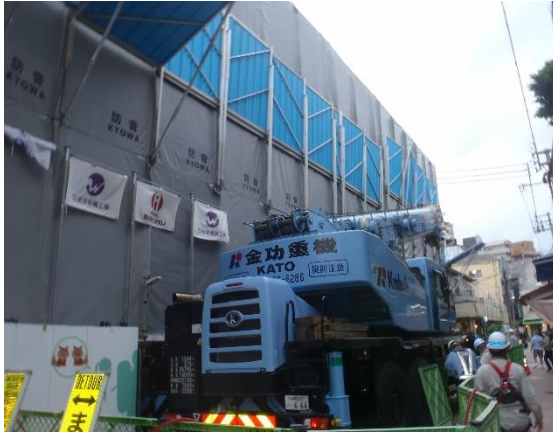
外部 東面 現況
