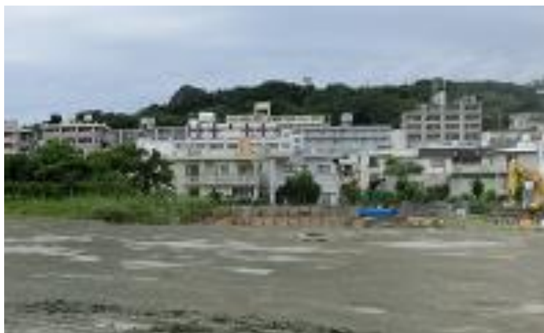
前年度施工済区域より施工現場を望む
