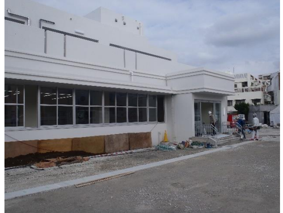
外部 南面 現況
