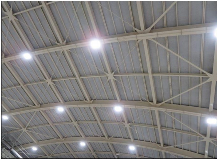
屋内運動場屋根鉄骨仕上り状況
