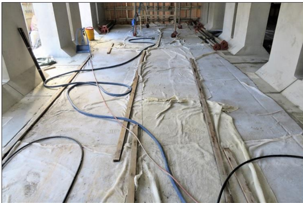
底版散水養生狀況
