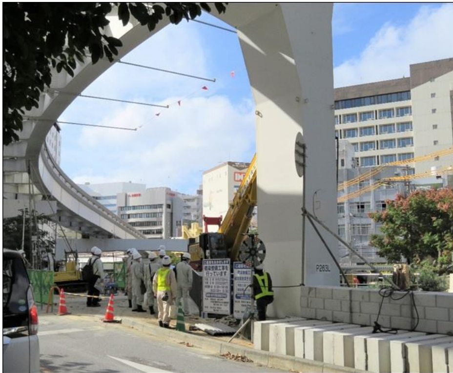
A1 橋台施工箇所の状況
