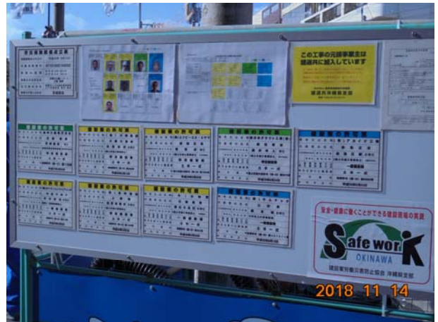
(護岸工 (地盤改良中))
