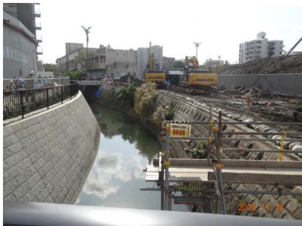
(護岸工 (地盤改良中))
