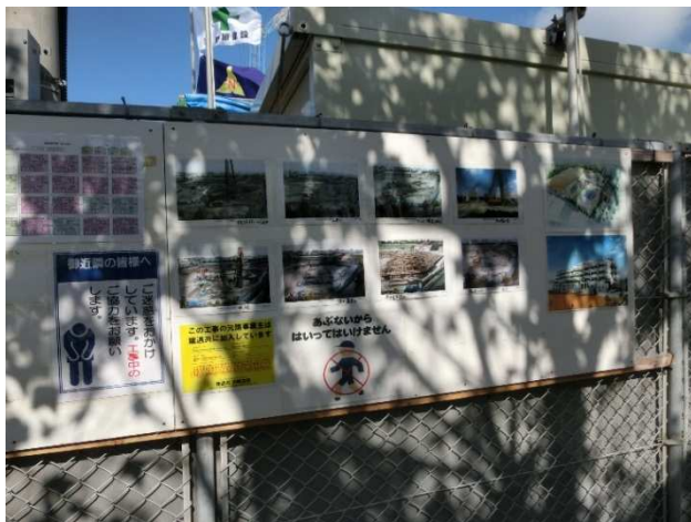
(写真-3 現場経過写真の掲出状況)
