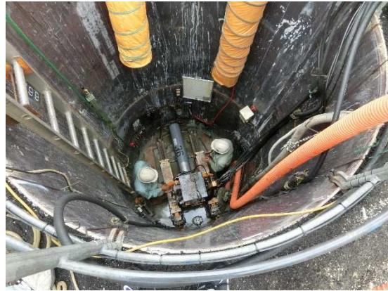
(写真-2 立坑内推進工施工中)
