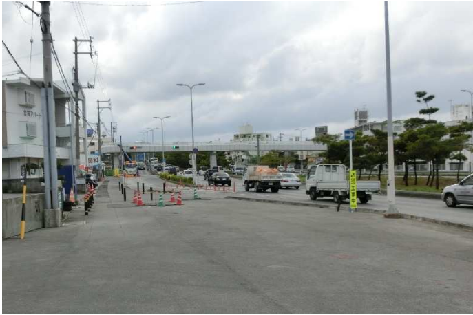
(写真-1 管路布設予定歩道)
