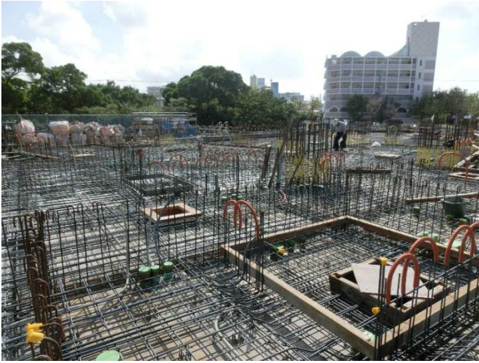
(写真-1 スラブ配筋状況)
