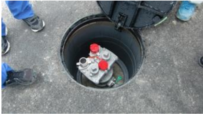
消火栓設置状況
