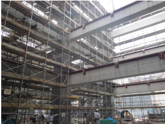
プレキャストプレストレスト コンクリート工事施工状況
