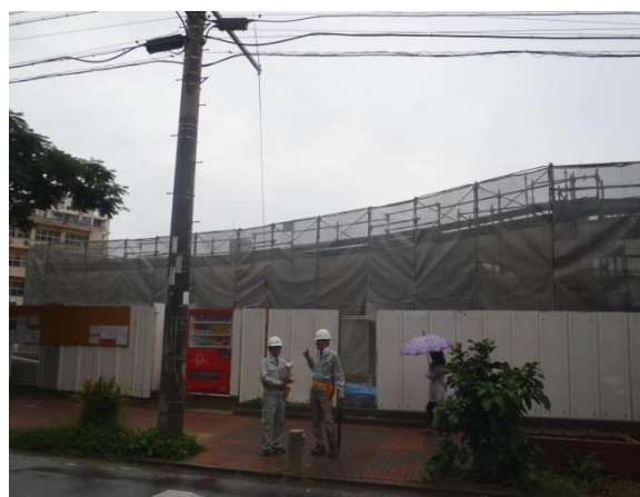
外部足場状況
