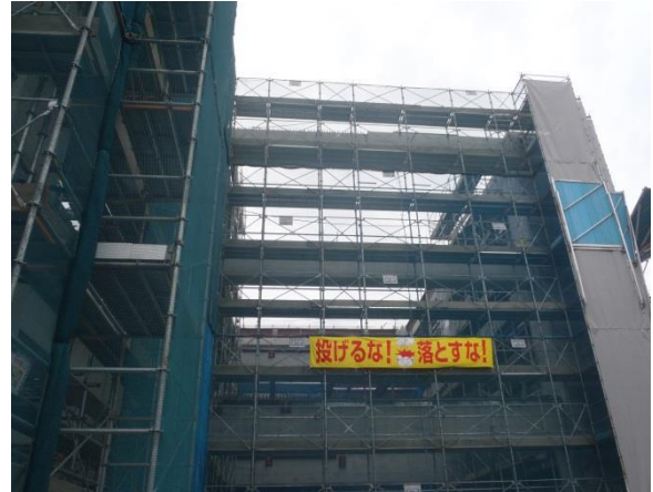
外部足場状況
