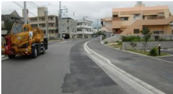
現場全景・布設替仮舗装部
