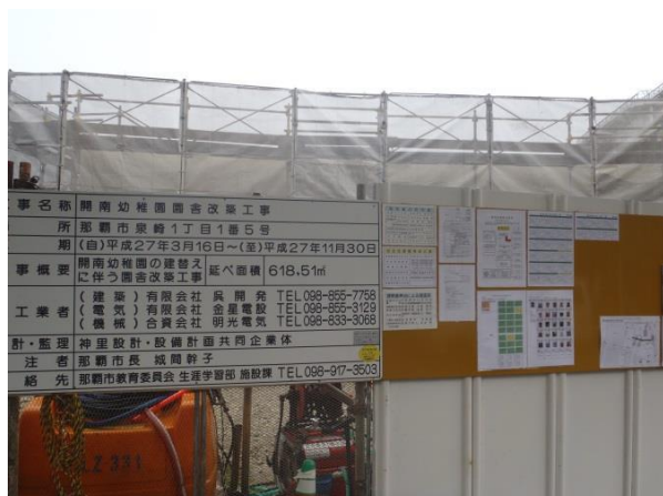
工事名看板、建設業許可標識 労災保険関係成立票、
