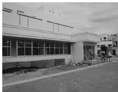
外部 南面 現況
