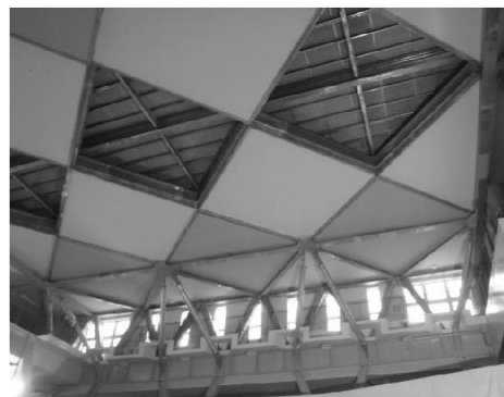
内部 吹き抜け部天井 現況
