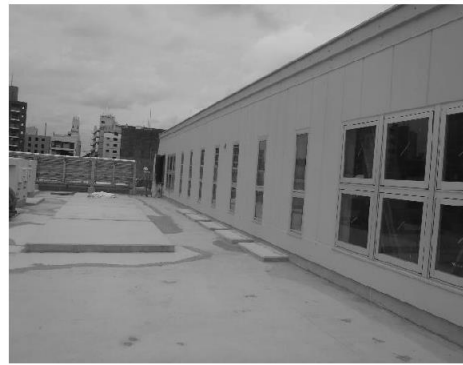
屋上 室外機置場 現況
