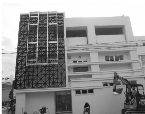
外部 北面 現況
