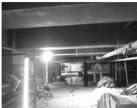
地下1階 ピット部 現況
