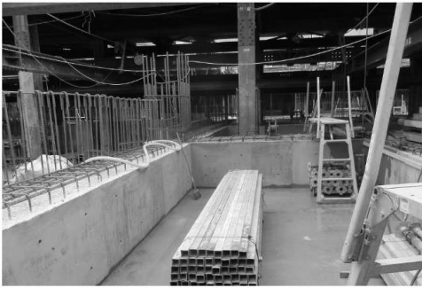
地下ピットの施工状況
