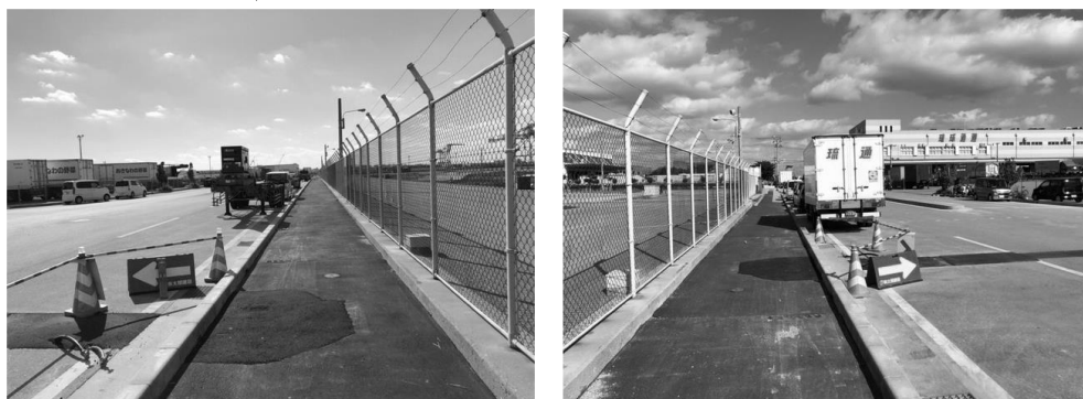
A・B結節点よりALine 舗装復旧後 (南方向)
