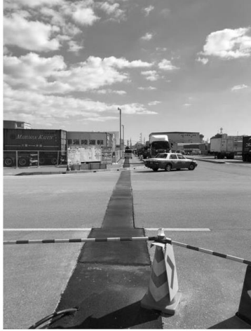
A・B結節点よりBLine 舗装復旧後
