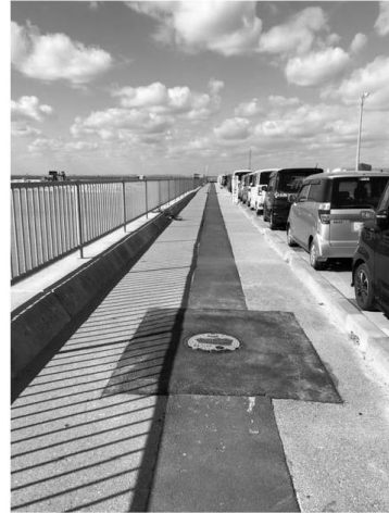
消火栓設置箇所とALine 舗装復旧後
