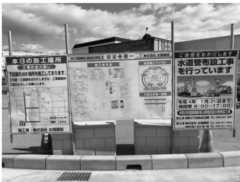
工事看板等の表示 (全体)
