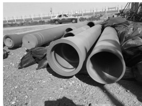
資材置き場でのDX形ダクタイトイル 鑄鉄管保管状況
