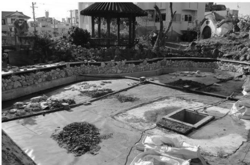
施工中の桃花溪
