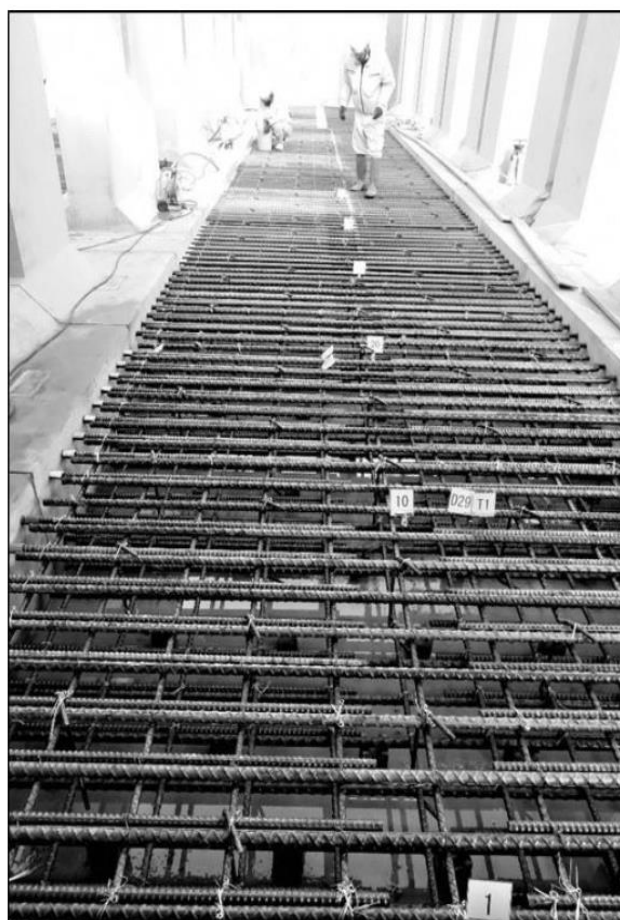
底版鉄筋組立状況
