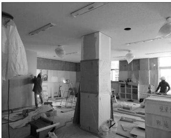
児童クラブ施工状況（内装・建具工事）
