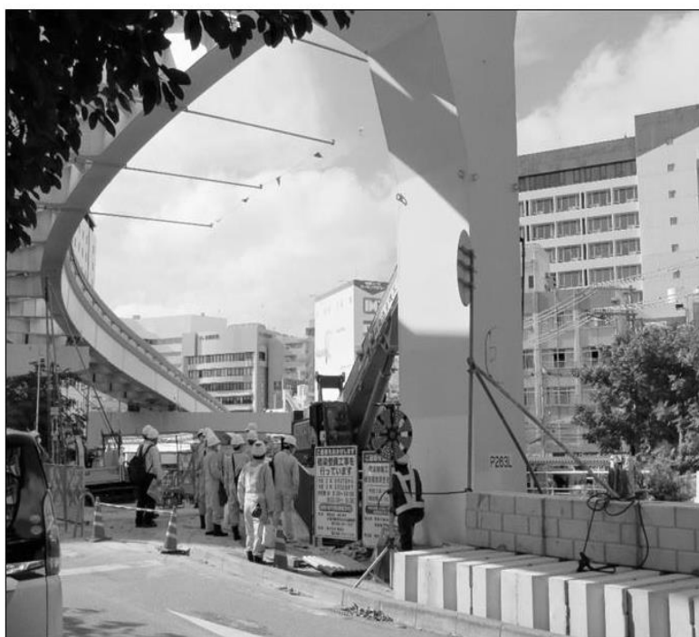
A1 橋台施工箇所の状況
