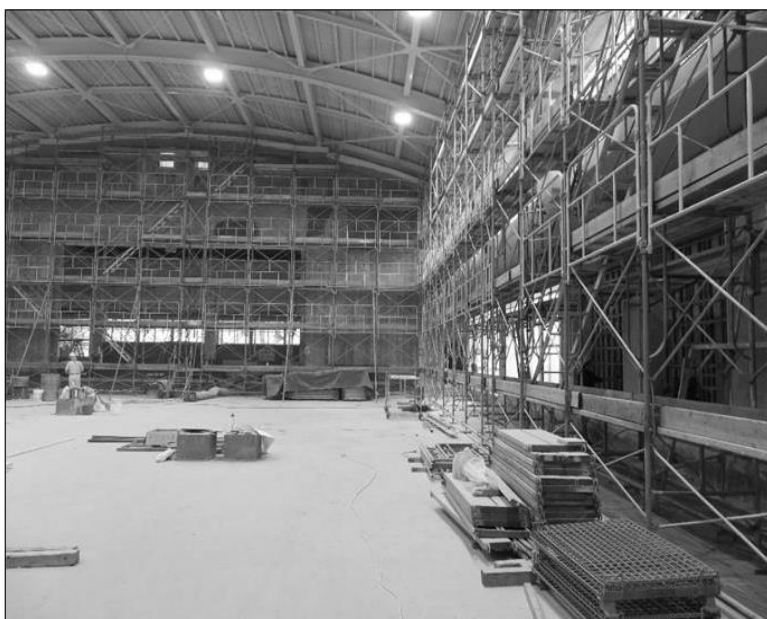
アリーナ床面状況、足場・昇降設備設置状況
