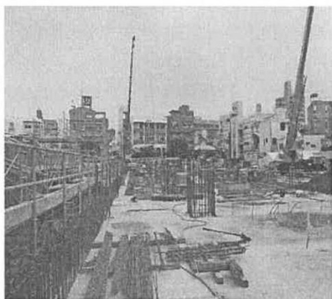
1階 南東部 現況
