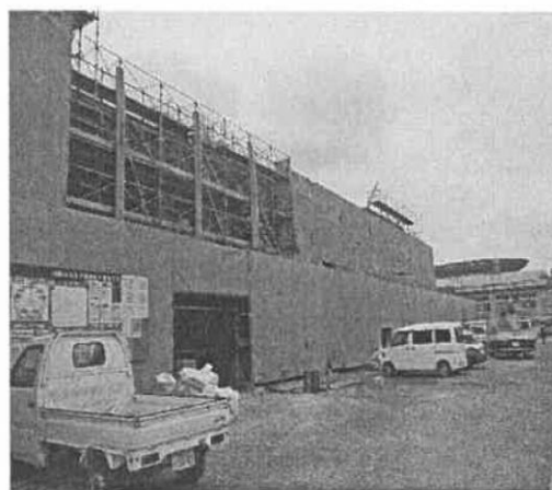
外部 北面 現況
