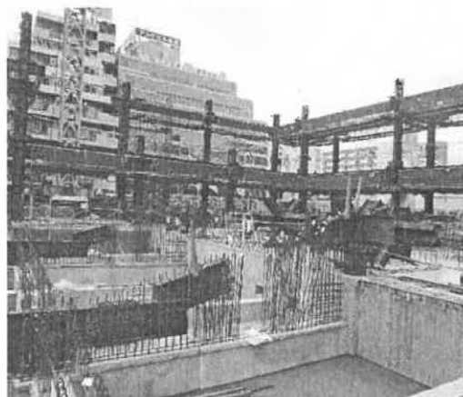
1階 大ホール 現況
