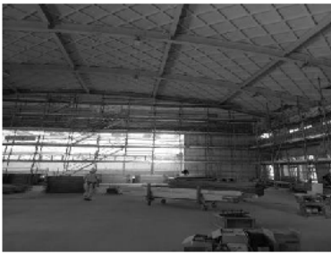
写真4 屋内運動場天井
