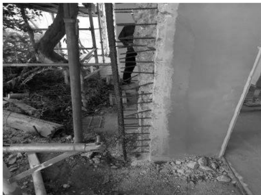
写真 7 1 階柱塩害補修
