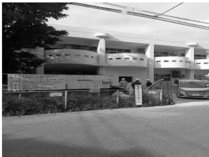
写真9 南面及び工事看板
