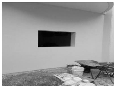
写真 10 耐震壁増設完了
