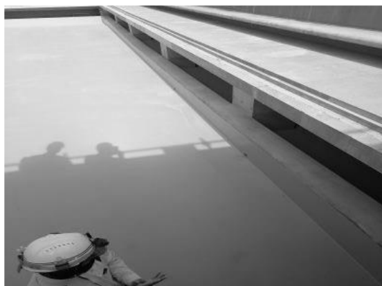
写真 6 プールピット部 防水立ち上がり
