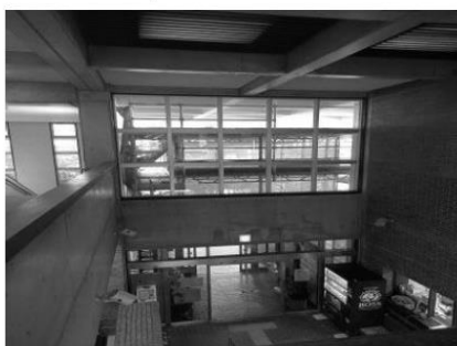
写真 12 ホール上部建具改修
