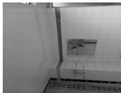
写真 11 浴室腰壁耐震スリット設置
