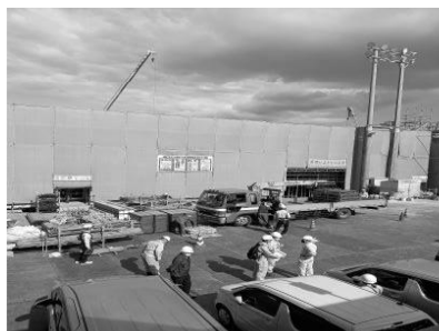
写真 1 現場正面全景
