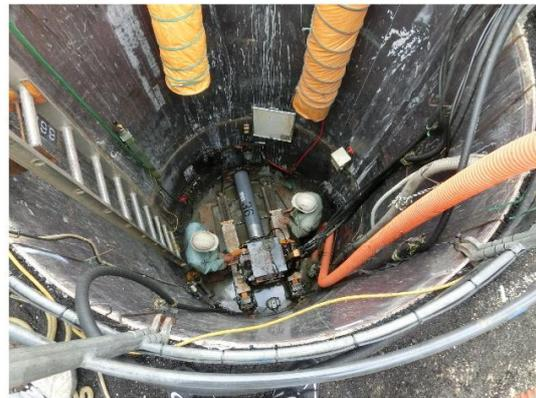
(写真-2 立坑内推進工施工中)
