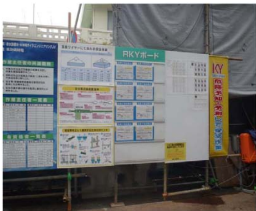
安全掲示板 建退共適用標識
