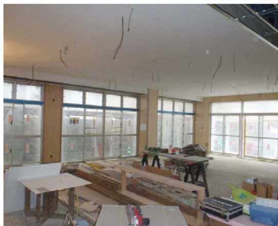
ホール仕上げ状況
