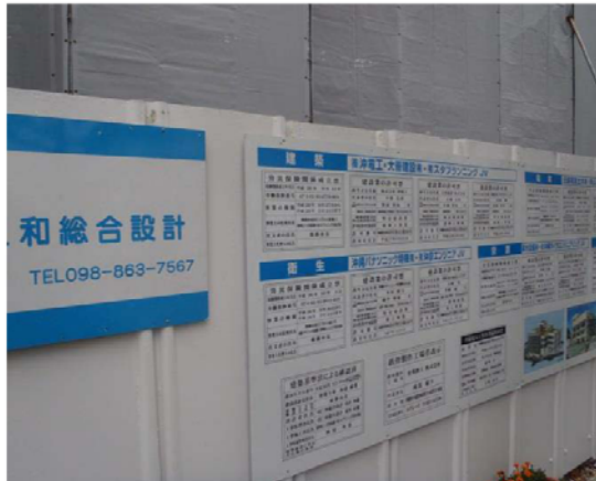
工事名看板、建設業許可標識 労災保険関係成立票
