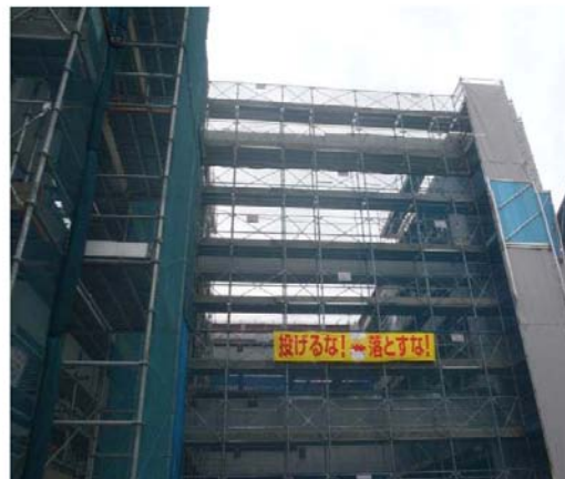
外部足場状況
