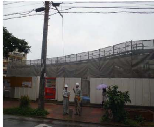
外部足場状況
