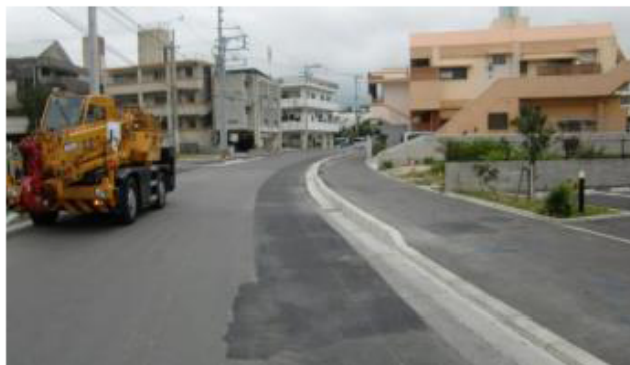
現場全景・布設替仮舗装部
