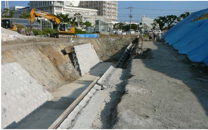
〔写真-5.間知ブロック積施工状況・下流部より上流部を望む〕
