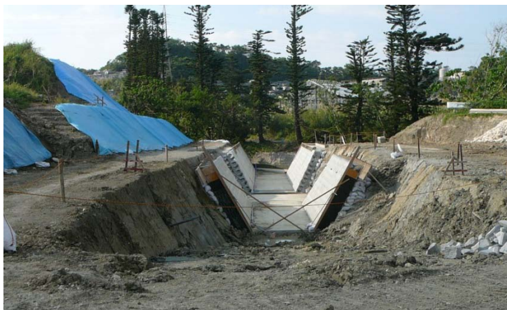
〔写真-4.間知ブロック積施工状況・上流部より下流部を望む〕
