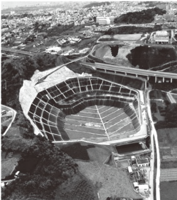
旧最終処分場（埋立前）
