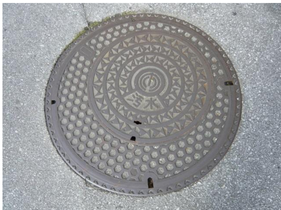
（宇栄原污水マンホール）
