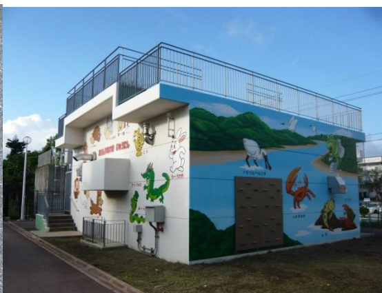
（古波蔵雨水ポンプ場）
