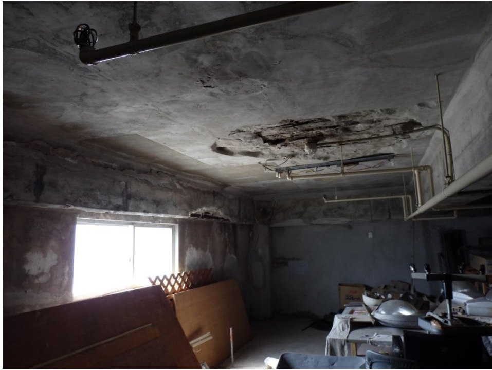
第一牧志公設市場 4階機械室内、天井などの剥離がひどい。
