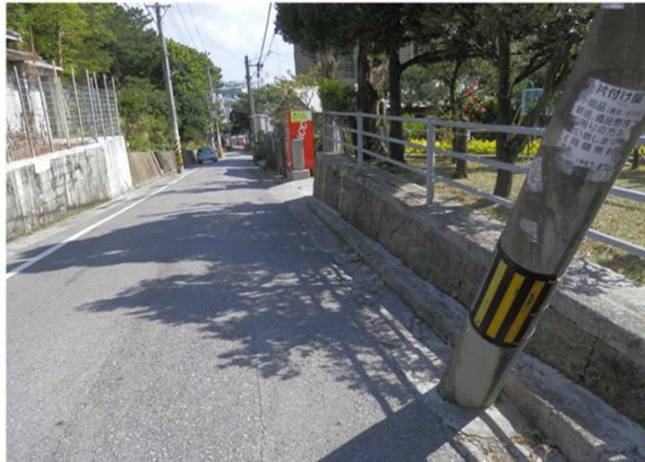
現在の道路は歩道が未設置
