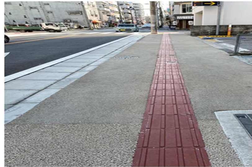
歩道を新設 乗入口でも段差が生じない（セミフラット形式）
