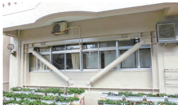
校舎耐震改修
