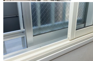
全住戸の内窓設置を実施
