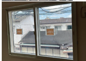
主居室の南側に内窓設置
