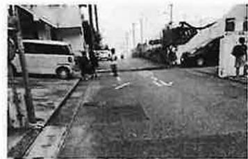
市道国場6号(県営国場団地付近)
