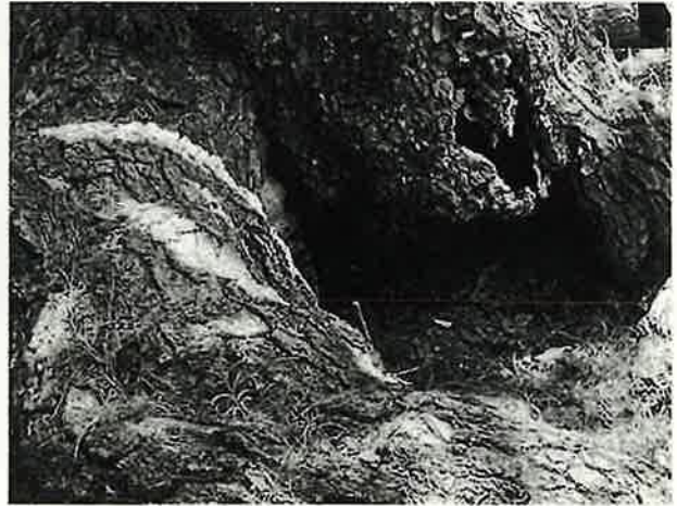
幹の根元部分が空洞化している様子
