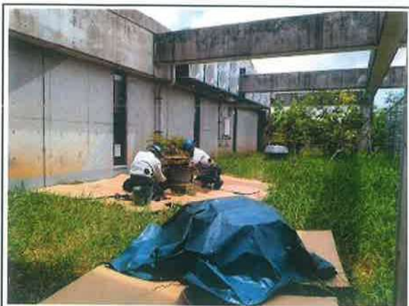
①シャワー室側取替状況
