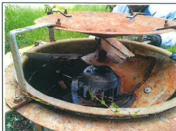
④既設ルーフファン取外し
