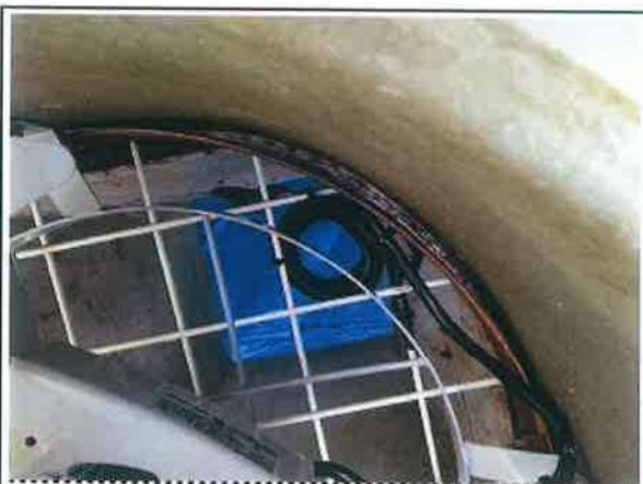
③配線接続
