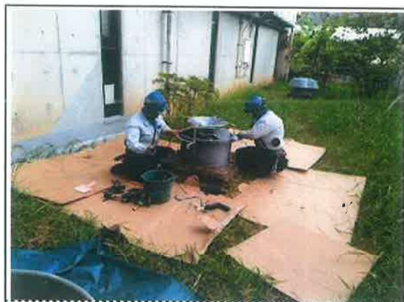
②新設据付状況
