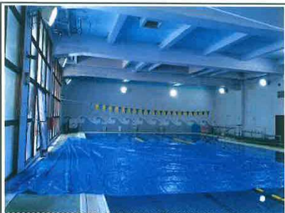
③プール側養生状況
