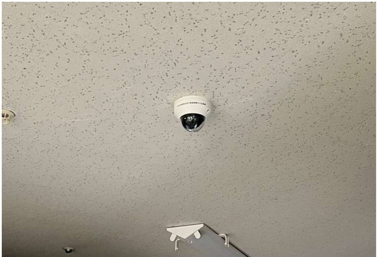
(エントランス・ロビー②)
