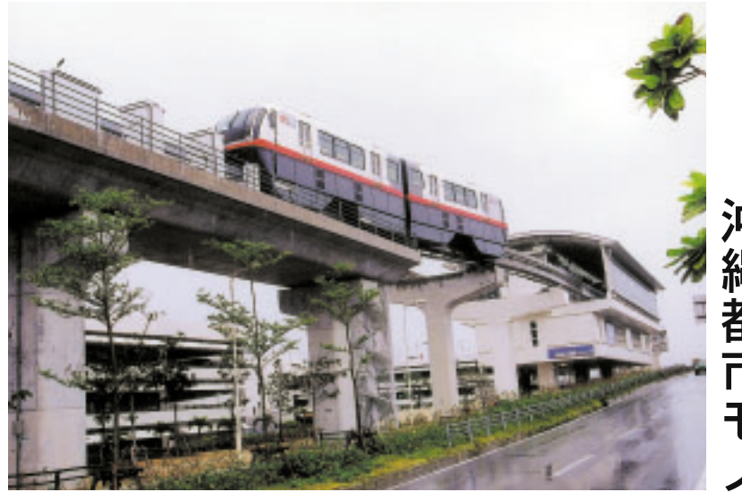
銀色に朱色の帯をしめたスマートな車体が那覇空港駅からレール上に滑り出しました(12月4日午前10時30分)
