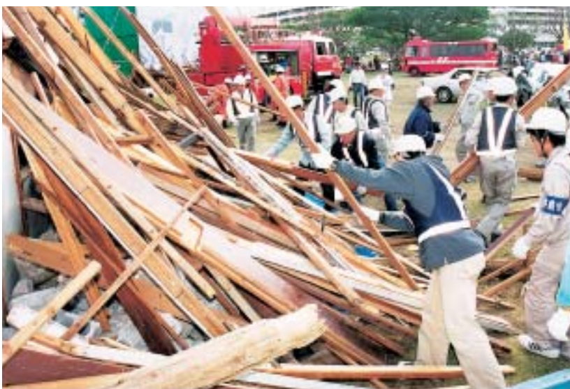
倒壊建物の瓦礫を撤去する市職員
