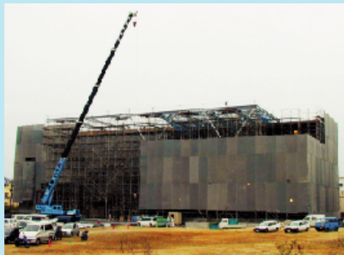
5月の移転をめざして、建設がすすむ新都心銘苅庁舎
