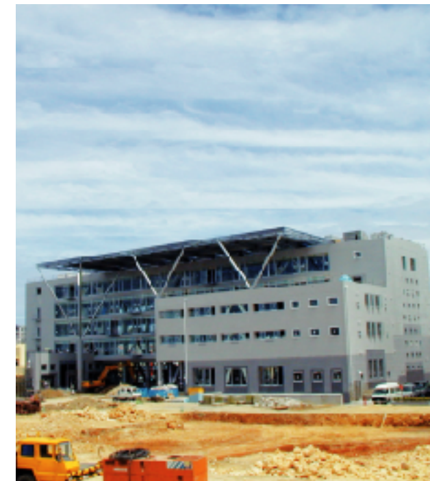
工事が進む新都心銘苅庁舎
