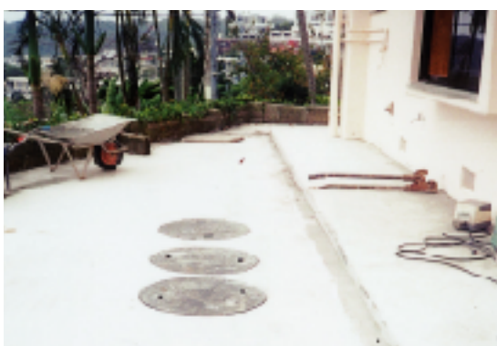
合併処理浄化槽を設置した住宅(首里山川町1丁目)
