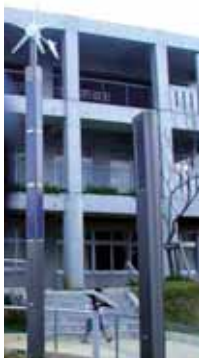
市立宇栄原小学校に設置されている太陽光・風力ハイブリッド発電設備
