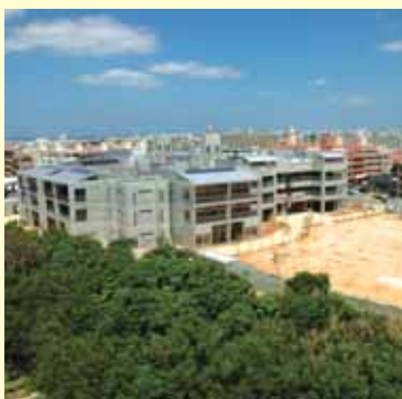
太陽光発電と風力発電機の設置のほか雨水利用など環境に優しい校舎で新学期がスタート(4日)
