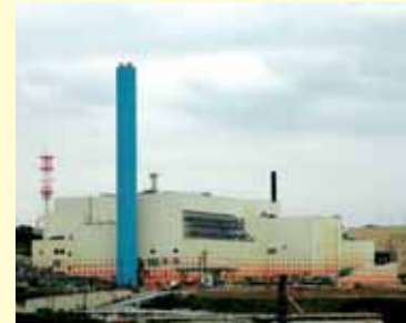
4月1日から本稼働に備え、昨年12月1日からはテスト稼働もはじまった(15日)
