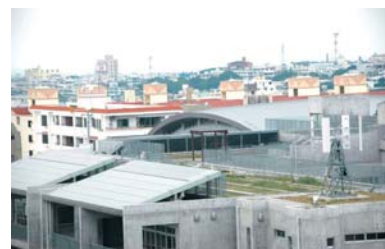
校舎の屋上でくるくるまわる風力発電と太陽光発電システムのソーラーパネル。
