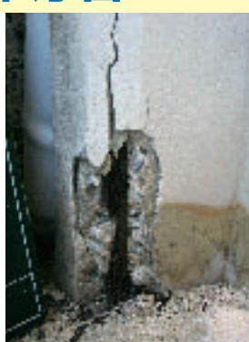
庁舎柱のひび割れ
