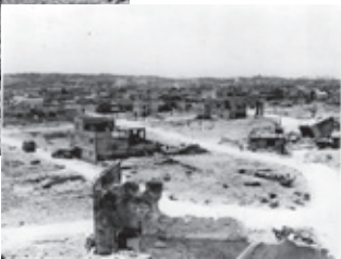
徹底的に破壊しつくされた那覇市街
