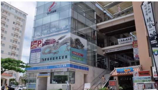
3階には市民活動の拠点施設「那覇市NPO活動支援センター」を設置
