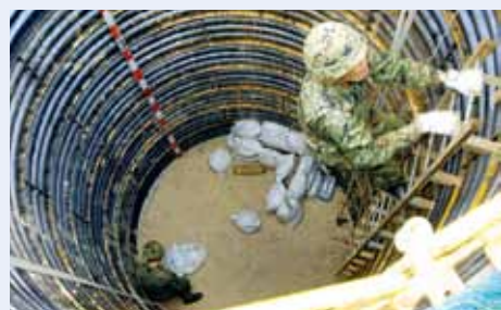
ライナープレートを使った安全化処理作業
