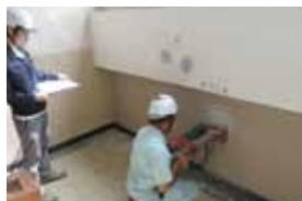
コンクリート強度調査
