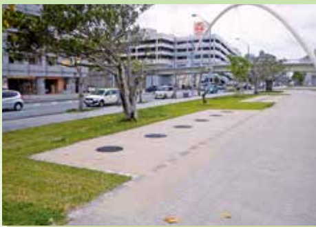
▲防災対策検討女性チームが提言する新都心に整備された災害用トイレのための汚水マンホール(便座やテントなどの上物は近くの施設で保管)
