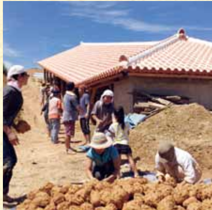
窯の天井にのせる土を運ぶ様子
