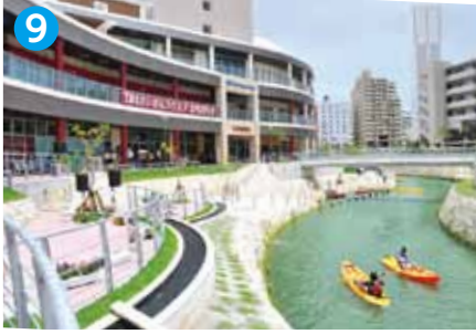
さいおんスクエア(安里川親水公園) 平成23年オープン。地区内を大きく蛇行して流下していた安里川の流れを緩やかにし、断面積を広げた。水辺に近づく、ウナギ、カニ類、ミナミトビハゼ等の豊かな生態系が観察できる。琉球王国時代の政治家・土木技術者である蔡温の名を冠した蔡温橋のたもとにある。
