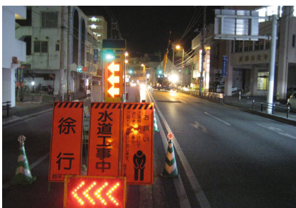
(写真4) 夜間工事中
