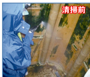
藻の発生：内壁に繁殖した藻類の膜がはがれ浮遊物が流出します。
