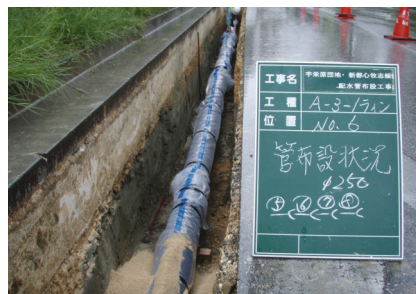
(写真2) 水道管の布設状況
