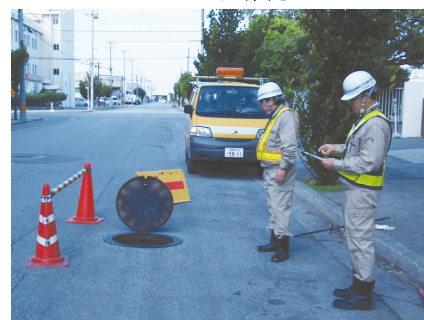
下水道のマンホール調査
