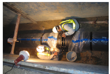
(写真6) 水道管を継いでいるところ
