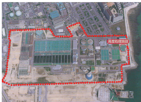
那覇浄化センター
