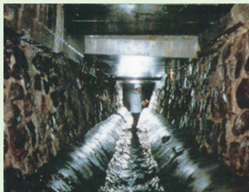
太閤下水 写真提供：大阪市建設局
