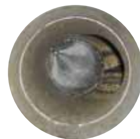
高圧洗浄中の管内部の様子
