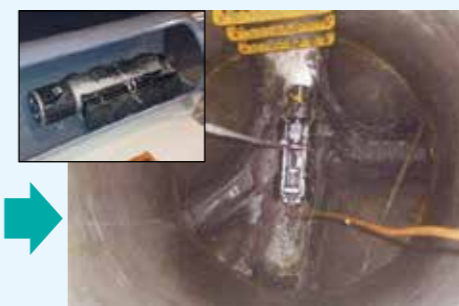
管の中をカメラで点検
