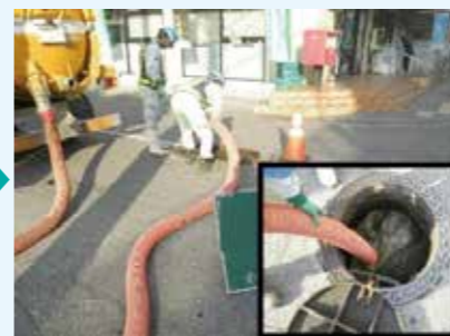
高圧洗浄車で土砂を清掃します。
