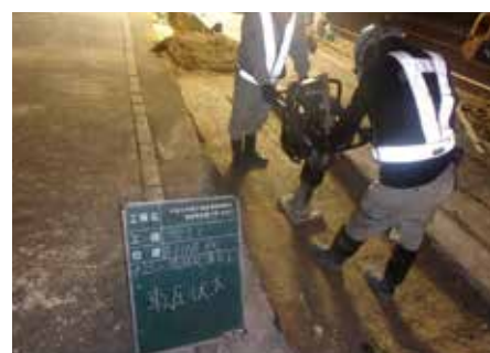
⑥埋戻し・締固め 道路に凸凹ができないように埋戻します。
