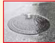
汚水があふれている状況
