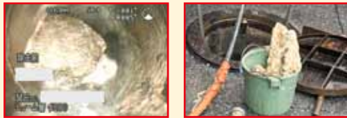
管内つまり状況の例 管内から除去された油塊の例
