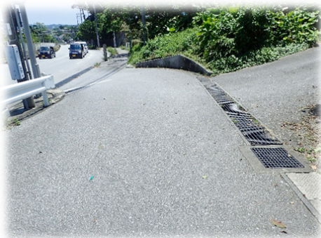
① 普段は乾いている道路の写真
