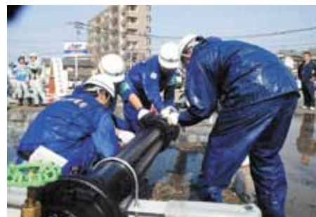
↑ 配水管修繕訓練 3
