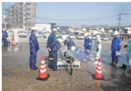
↑ 配水管修繕訓練 2
