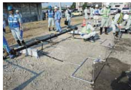
↑ 仮設給水栓設置訓練
