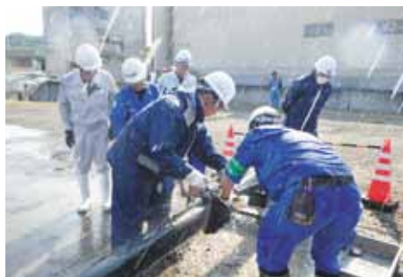
↑ 配水管修繕訓練 1
