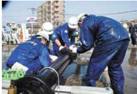
↑配水管修繕訓練 3
