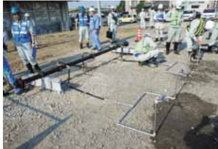
↑仮設給水栓設置訓練
