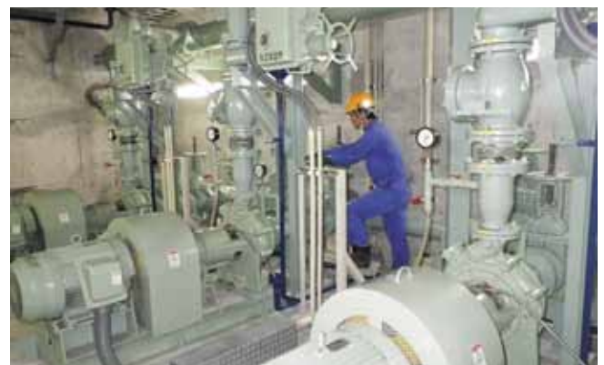
圧送ポンプ、配管、バルブ点検作業の様様
