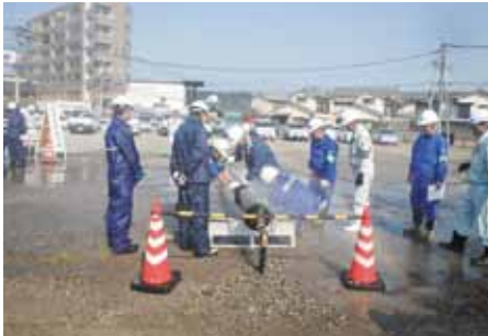
↑配水管修繕訓練 2
