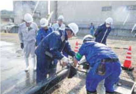
↑配水管修繕訓練 1
